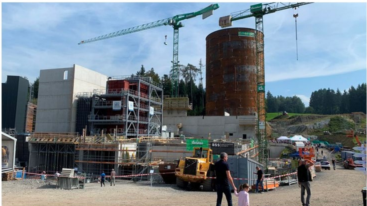
Die Baustelle der Agro Energie Rigi. (Bilder Josef Scherer)
